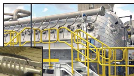
Дисковый фильтр, работающий под давлением
